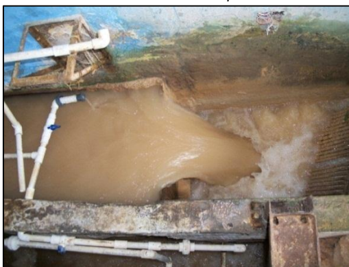
Canal de Aforo PTAP del Municipio de Cimitarra.
